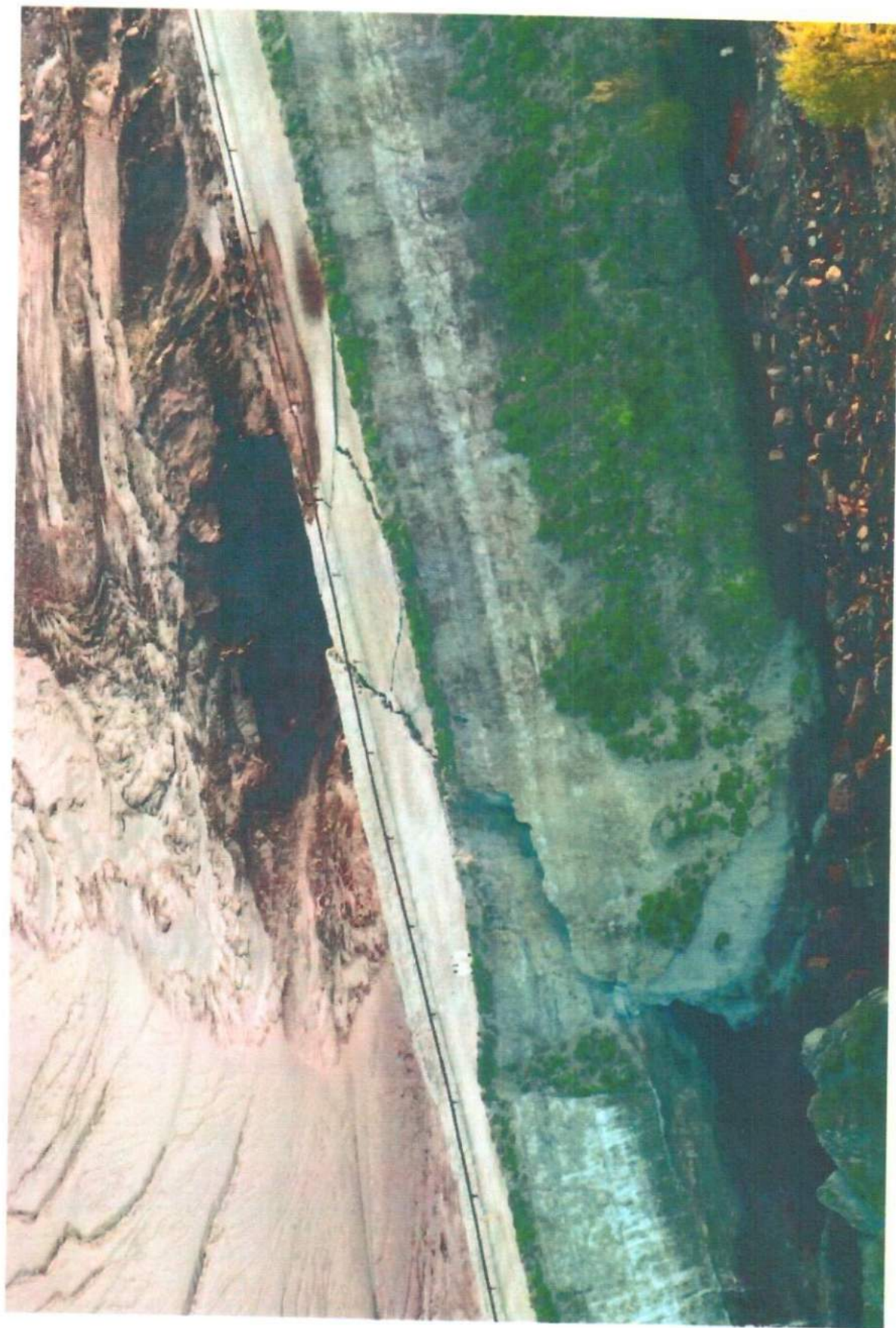
A X. KAZETTA ÉSZAKI TÖLTÉSÉNEK KÖZEPE - KÖZVETLENÜL A ROBBANTÁS UTÁN. A BOMBATÖLCSÉR NYOMA A VÖRÖSISZAPBAN, A RIDEG TÖLTÉS CSUPÁN ELTÖRT, DE NEM SZAKADT KI!
